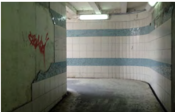
Passage sous la voie ferrée à l'entrée Sud de la ville
