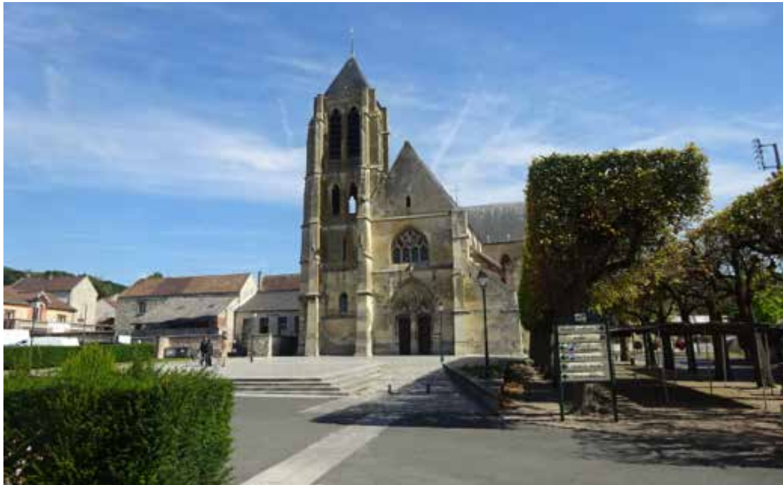
EGLISE DE BESSANCOURT
