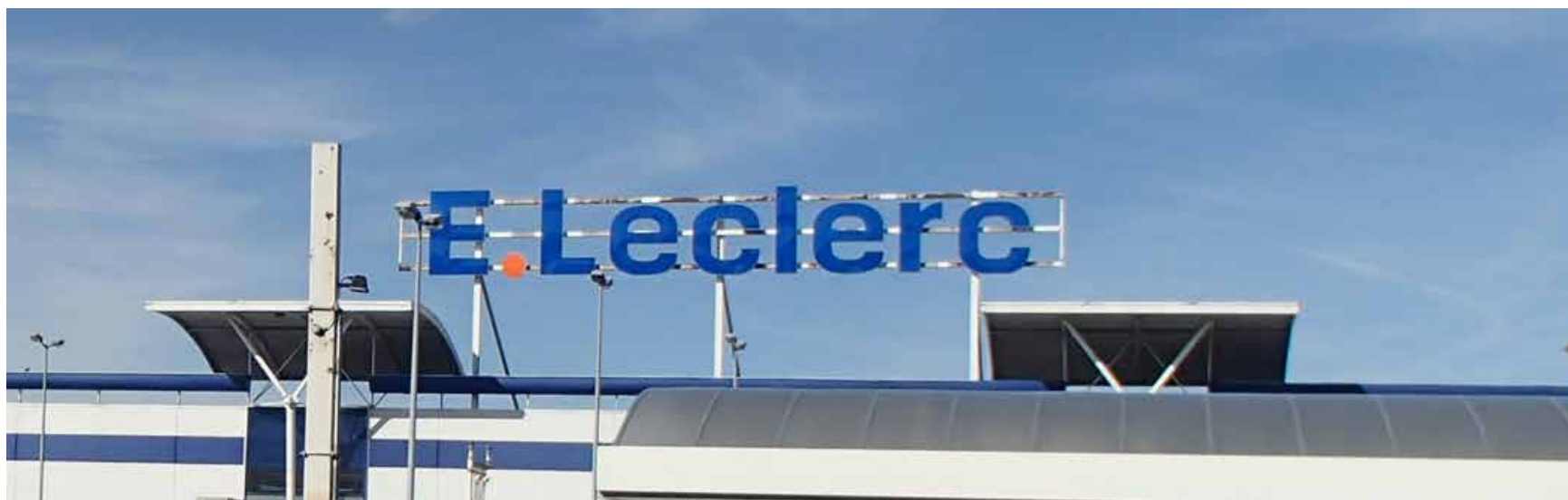
ENSEIGNE EN TOITURE DONT LES SUPPORTS NE SONT PAS DISSIMULÉS DONC ILLÉGALE
