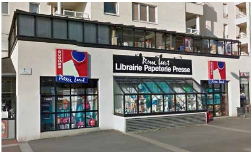
BONNE INTÉGRATION - ERMONT
