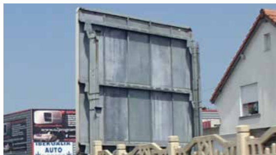
DÉFAUT D'HABILLAGE DU DOS
